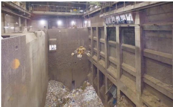
① ごみピット・ごみクレーン
