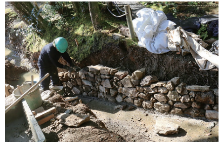
水路改修工事
