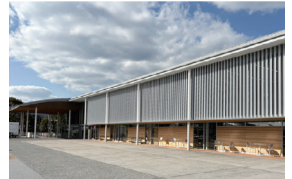
改修工事を終えた道の駅「仁保の郷」本館棟
