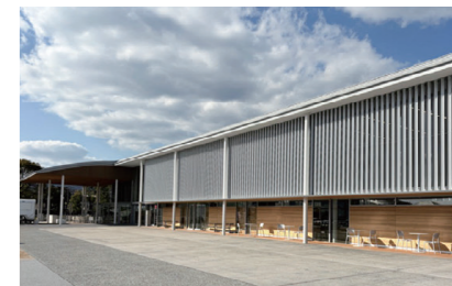
改修工事を終えた道の駅「仁保の郷」本館棟
