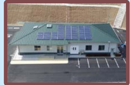
かんりとう 管理棟・浸出水処理施設
