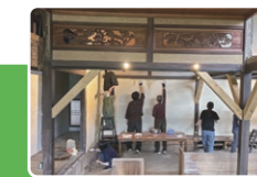
古民家の改修体験(山口市)
