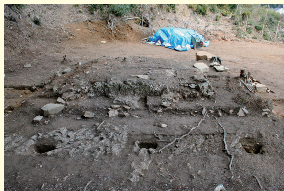
山王社本殿跡の調査状況
