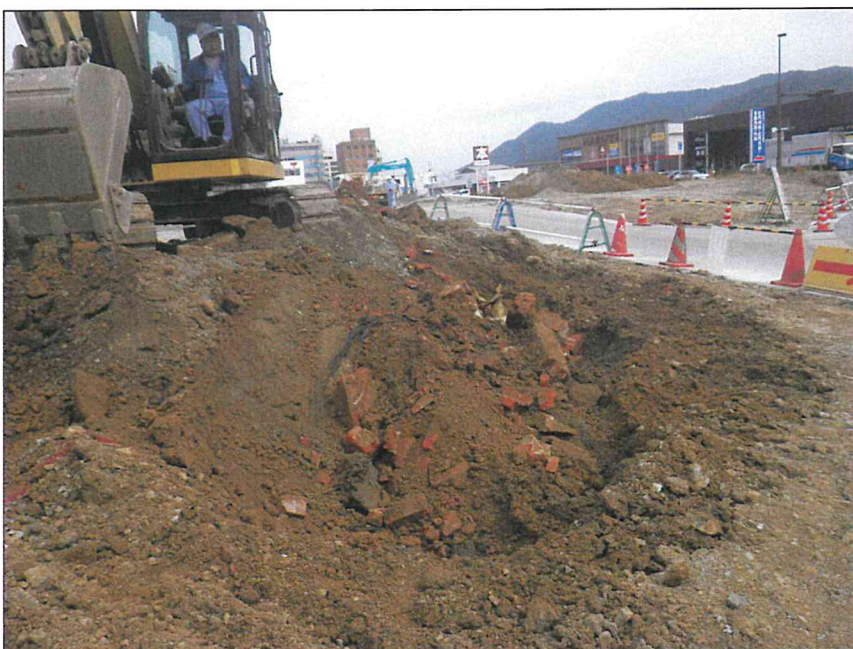
写真区分:その他 工種:床掘り時ガレキ
