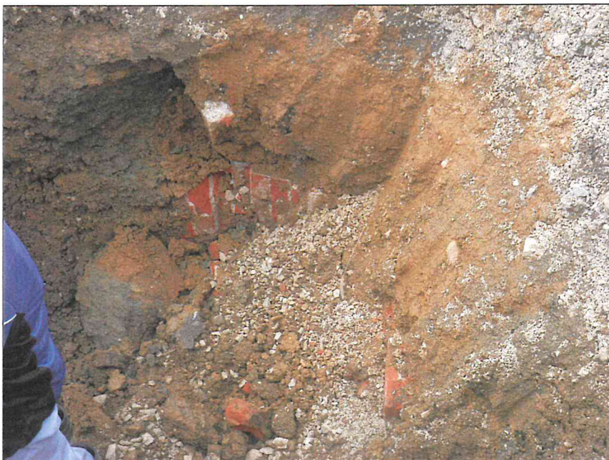
写真区分:その他 工種:床掘り時ガレキ
