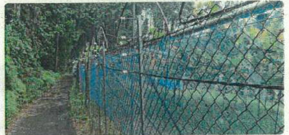
侵入防止柵の設置
