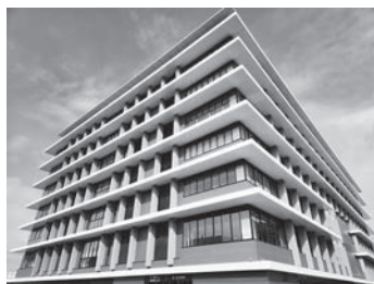
新本庁舎棟の外観
