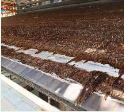
葺き替え前の屋根の状況
