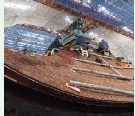
屋根葺き替え作業
