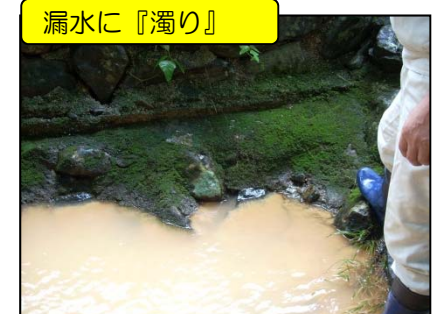
『漏水』『パイピング孔』の例
