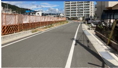
道路（長谷駅南線、金池線）
