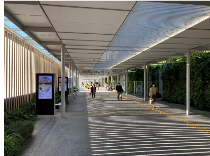
新山口駅南北自由通路の整備状況
