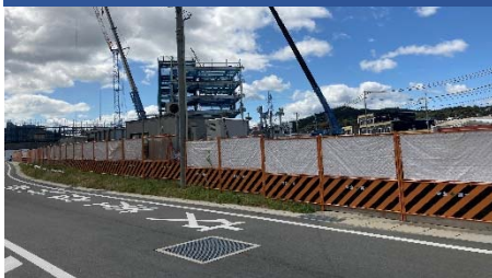
（仮）新山口駅拠点施設 建設中
