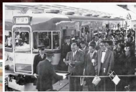
小郡駅以西電化完成 (昭和36(1961)4.20)
