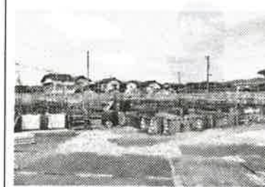
続・センター建替基礎工事 （R7.6.23撮影）
