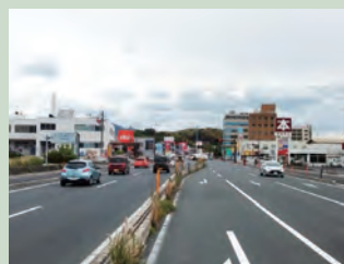
4車線化後の国道9号
