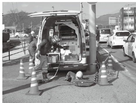
下水道管点検の様子
