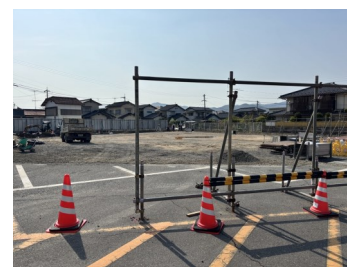
地域交流センター建替着工 (R7.4.16撮影)
