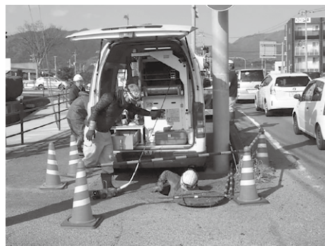
下水道管点検の様子
