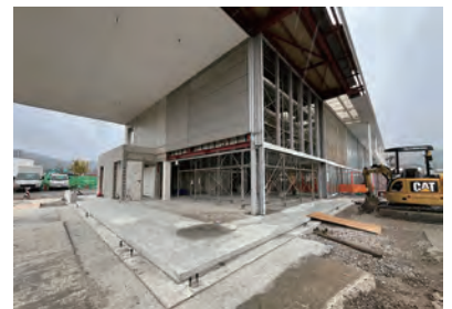
改修中の道の駅「仁保の郷」の様子
