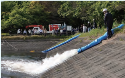
稼働中の移動式排水ポンプの様子
