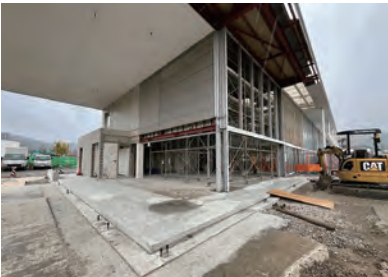
改修中の道の駅「仁保の郷」の様子
