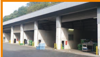
小郡資源物ストックヤード
