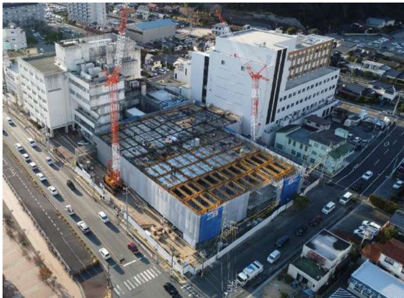
建設中の南棟
