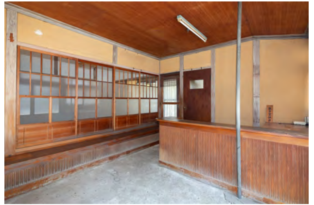
店舗兼主屋内部
