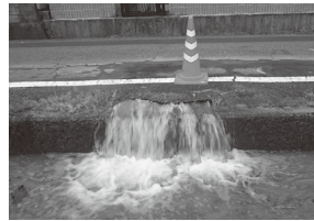
▲水道管からの漏水
