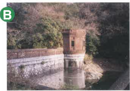
元上水道貯水池堰堤(国の登録有形文化財)
