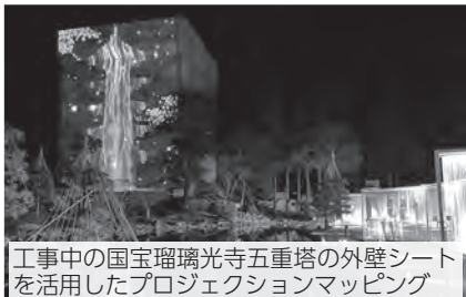
工事中の国宝瑠璃光寺五重塔の外壁シートを活用したプロジェクションマッピング
