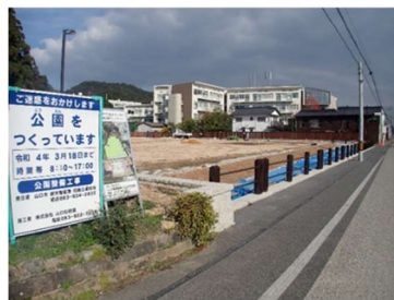
【措置 19】 築山跡の整備工事
