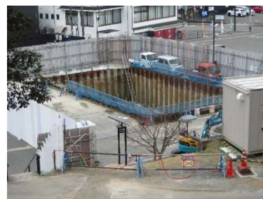
【措置 22】 瑠璃光寺五重塔防災設備工事
