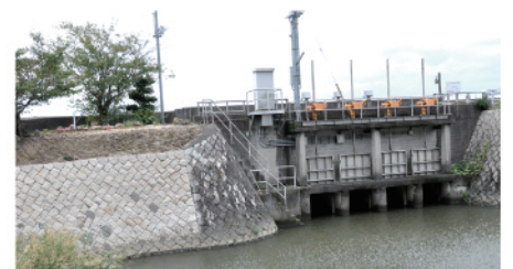
南蛮樋/陸側に南蛮樋門(遮蔽板を上下に動かす)、海側には唐樋門(遮蔽板を海水圧で動かす)となっていて機能が比較でき、昔は石門の板戸でした。
