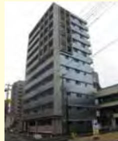
黄金町市営アパート (平成23年)
