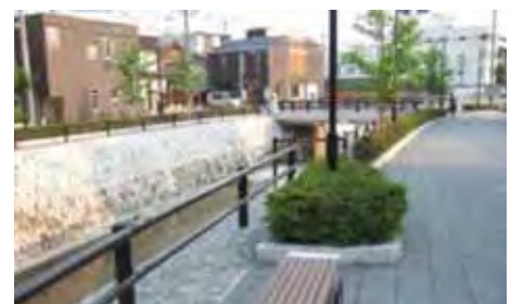
一の坂川周辺整備
