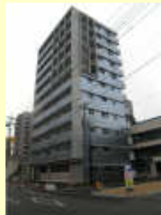
黄金町市営アパート (平成 23 年)
