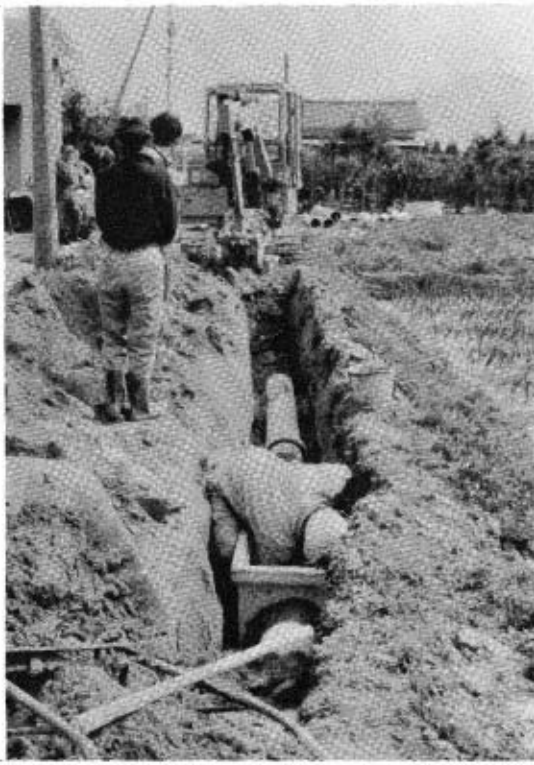
天神町区の生活排水工事
