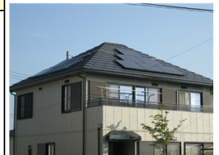
住宅用太陽光発電システム設置
