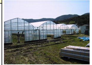
ビニールハウスの整備
