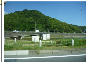
東津橋歩道橋（小郡下郷）工事中
