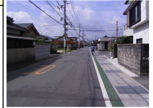
市道若宮町中矢原線（側溝蓋掛）
