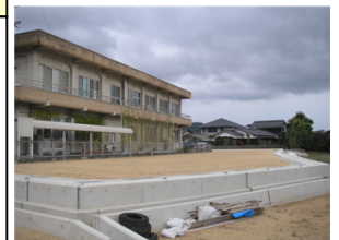
嘉川地域交流センター 造成工事
