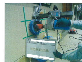
耐震診断調査(コア採取状況)
