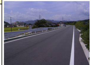
市道平井西岩屋線（平井～黒川）
