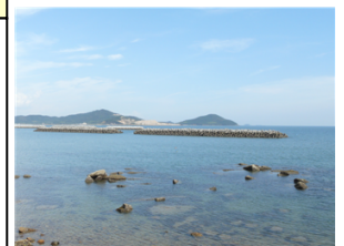
離岸堤（山口東港）
