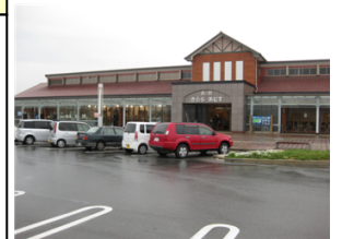
道の駅きらら あじす
