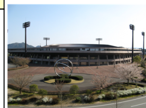
スポーツの森 西京スタジアム
