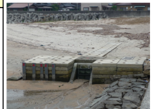
改良がすんだフラップゲート
