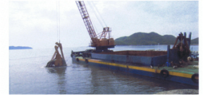
浚渫工事のようす
