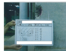
耐震診断調査(はつり調査状況)
