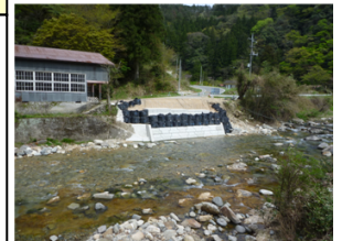
祖父第一橋（徳地野谷）工事中
