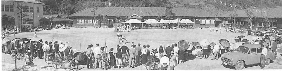
▲鳥地小学校 運動会（昭和34年撮影） 大正13年10月に校舎二棟が竣工し、昭和30年3月に階上に講堂をもつ木造二階建校舎が増築されました。
