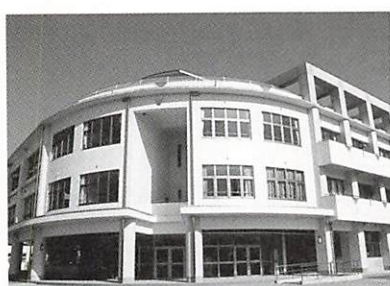
白石小学校新校舎は、市内小学校初の鉄筋コンクリート4階建て。自然素材を多く取り入れ、人にやさしい、新世代学習に対応する構造となっています。
