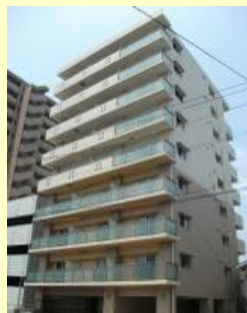
駅通り市営アパート (平成 22 年)
