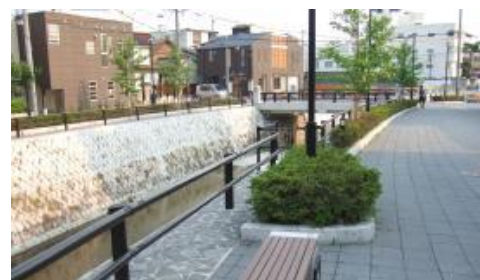
一の坂川周辺整備
