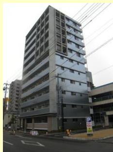
黄金町市営アパート (平成 23 年)
