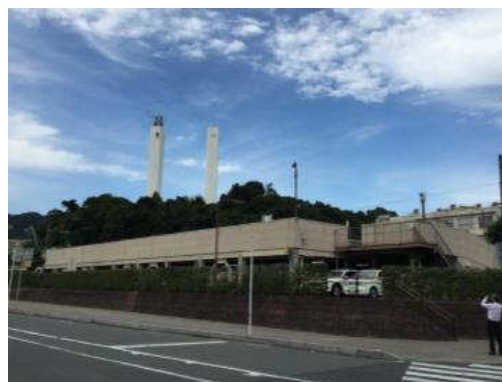
老朽化した中央駐車場
