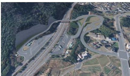
イメージ：湯田PAにおけるスマートインターチェンジ整備
