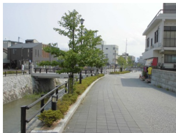
透水性舗装の整備 (上後河原道場門前一丁目線)
