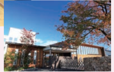
保育施設のさらなる整備を進めます（昨年5月に開園したみのり保育園）
