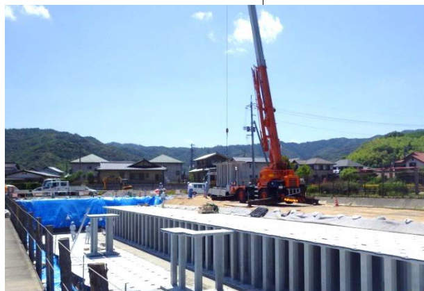
吉敷上東雨水貯留施設施工の様子
