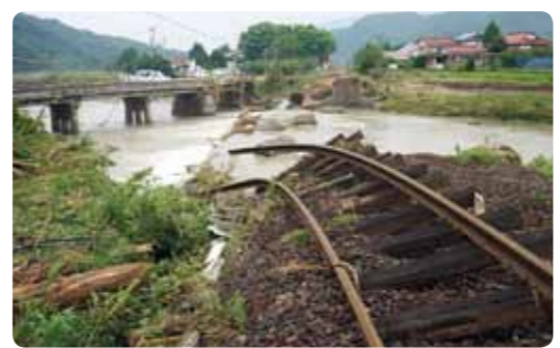
(上写真) JR 鍋倉駅付近の鉄橋をSLが走る。平成26年8月23日から全線運転を再開した。(下写真) 豪雨により流されたJR鍋倉駅付近の鉄橋。線路が途中で折れていた。
