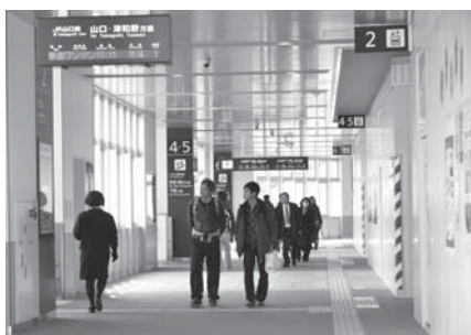
3月10日から部分供用を開始した新山口駅橋上駅舎（在来線および新幹線への連絡通路部分）
